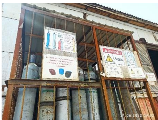
Фотография 15. Хранение пустых баллонов СП GE на стройплощадке (статус в июне 2023 г.)
