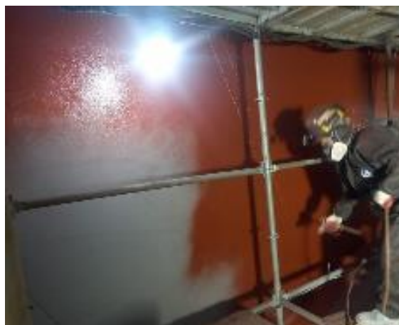
Фотография 48. Покрасочные работы на турбинном водоводе ГА №3 (статус в апреле 2023 г.)
