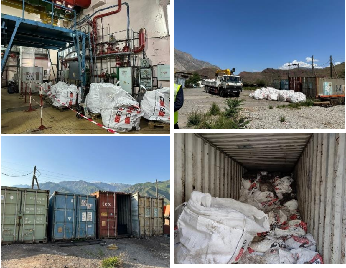
Фотография 32. Сбор и хранение мешков с асбестосодержащими отходами на специально отведенном участке хранения (статус в июне 2023 г.)
