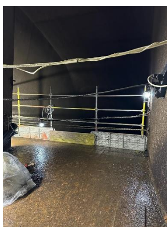
Фотография 51. Установлен барьер безопасности для строительства лесов в водоводе ГА №3 (статус в мае 2023 г.)
