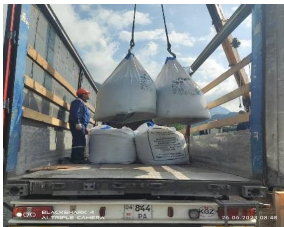
Фотография 31. Временное хранение абразивных отходов на стройплощадке СП ZMEC и транспортировка на утилизацию (статус в мае-июне 2023 г.)
