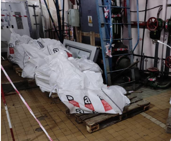
Фотография 42. Удаление асбестосодержащих отходов и работы по очистке асбеста (статус в марте, апреле 2023 г.)
