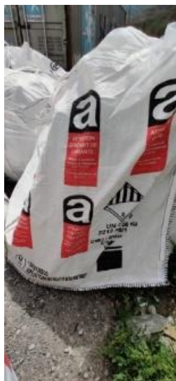
Фотография 18. Открытое хранение мешков с асбестосодержащими отходами на территории склада Токтогульской ГЭС (статус на 16 мая 2023 г.)
