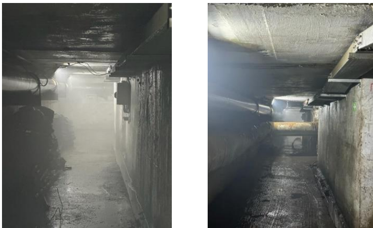
Фотография 25. Загрязненный воздух на отм. 707 м при проведении пескоструйных работ СП ZMEC (статус в июне 2023 г.)
