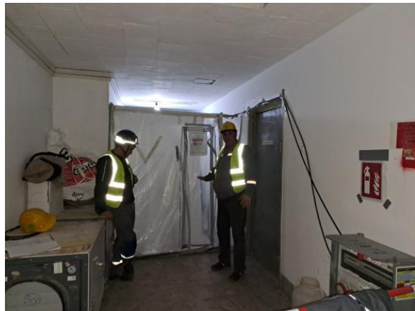
Фотография 42. Удаление асбестосодержащих отходов и работы по очистке асбеста (статус в марте, апреле 2023 г.)
