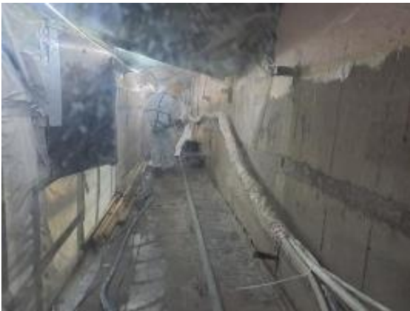
Фотография 42. Удаление асбестосодержащих отходов и работы по очистке асбеста (статус в марте, апреле 2023 г.)
