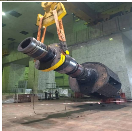
Фотография 41. Перемещение демонтированного оборудования с ГА №2 на склад Заказчика (статус в апреле 2023 г.)
