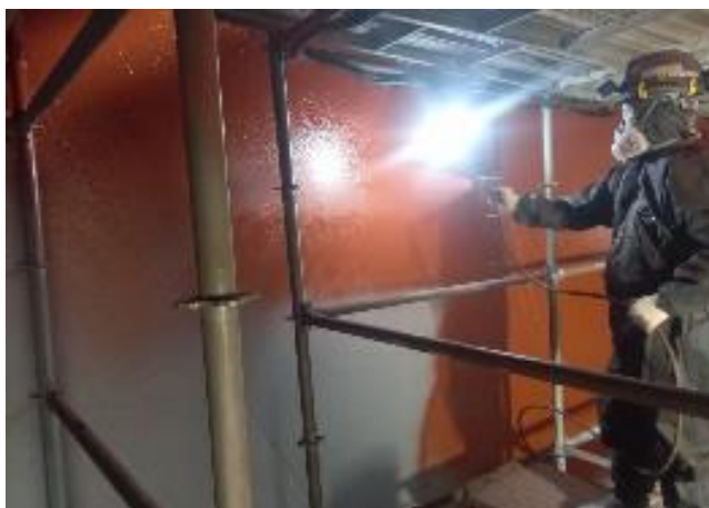
Фотография 48. Покрасочные работы на турбинном водоводе ГА №3 (статус в апреле 2023 г.)
