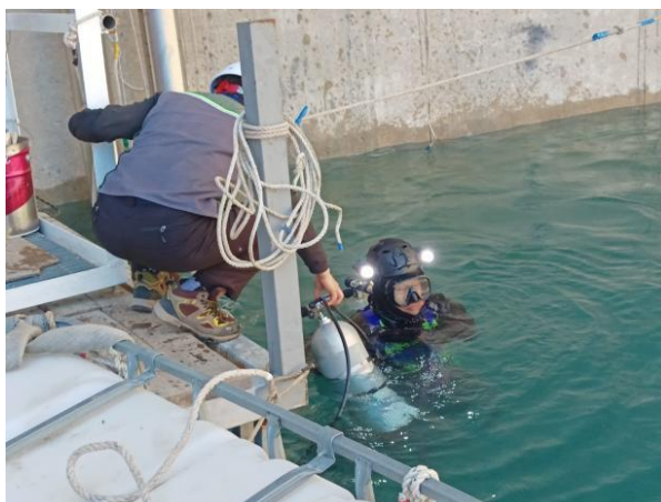
Фотография 49. Водолазные работы - монтаж аэрационных труб глубинного водосброса под водой (статус в апреле 2023 г.)
