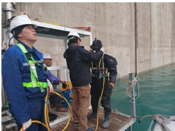
Фотография 49. Водолазные работы - монтаж аэрационных труб глубинного водосброса под водой (статус в апреле 2023 г.)
