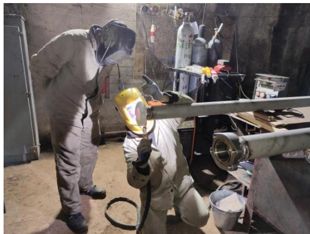
Фотография 45. Сварочные работы фланцев трубопровода на отм. 740 м (статус в апреле 2023 г.)
